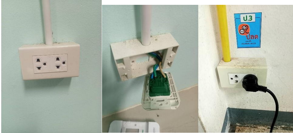
เต้ารับในอาคาร ต่อระบบสายดินตามมาตรฐาน
